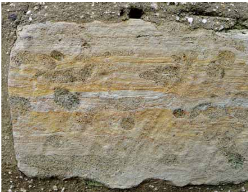
Detail van een Gobertangestein (kerk van Kumtich) met de typische heterogene structuur: gekleurde banden, fijne laminaties en groengrijze graafgangen.
