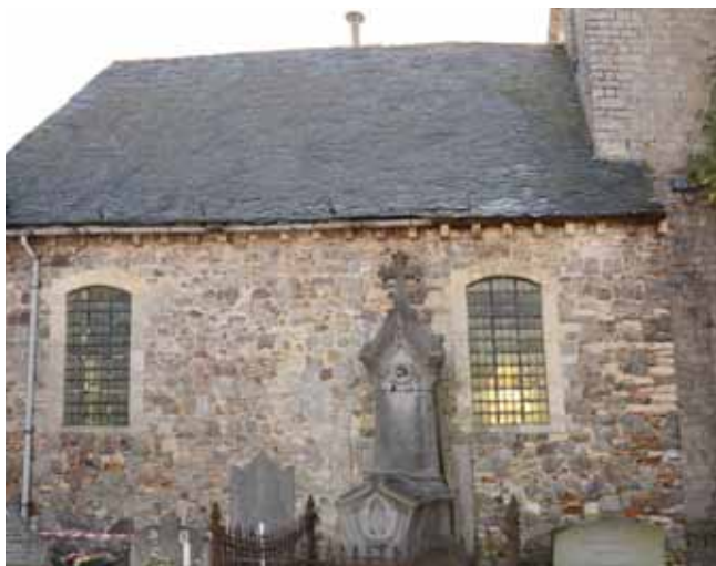
Het oudste deel van de kerk is te herkennen aan het ruwere metselwerk en de minder goed afgewerkte stenen.
